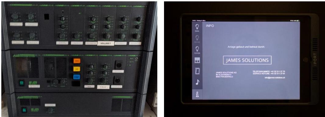
*Abbildung 1 Links die alte Bedienung der Akustikanlage, Rechts die Bedienung über das Tablet. Alle Funktionen der Anlage können über die intuitive Oberfläche abgerufen und gesteuert werden.*
