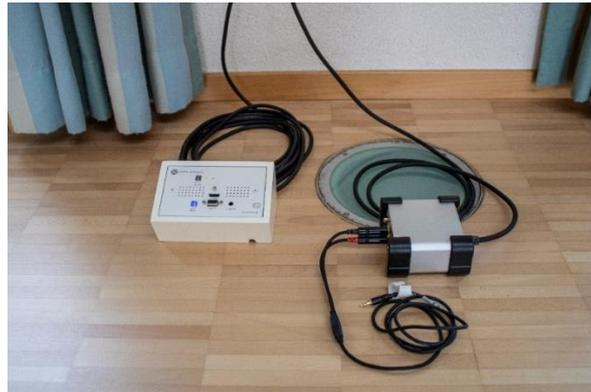
*Abbildung 3 Links im Bild die übernommene Video-Einspeisung, Rechts die neue DANTE-DI-Einspeisung von externen Video- und Audioquellen über das Netzwerk.*
